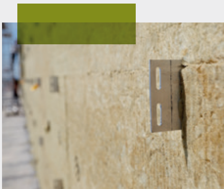
Système de fixation traditionnel en aluminium
