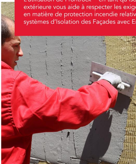
**ROCKWOOL Frontrock<sup>MC</sup> est un panneau d'isolation extérieure en laine de roche semi-rigide et à double-densité, conçu pour les systèmes d'Isolation des Façades avec Enduit (SIFE) fixés mécaniquement.**
