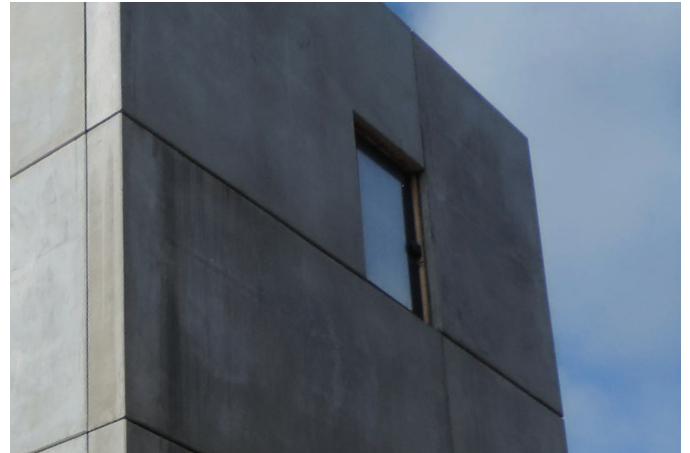
Esimerkki toleranssiluokan I seinästä.
