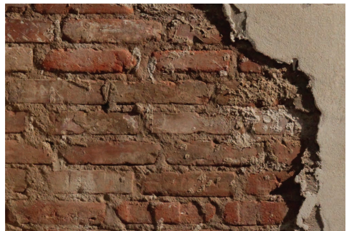
Esimerkki toleranssiluokan III seinästä.
