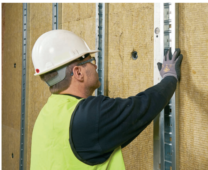
Asenna teräsrankat eristeen päälle pystysuuntaisesti.
