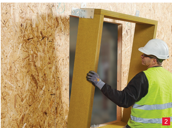
Redair Link -järjestelmä nostetaan paikalleen.
