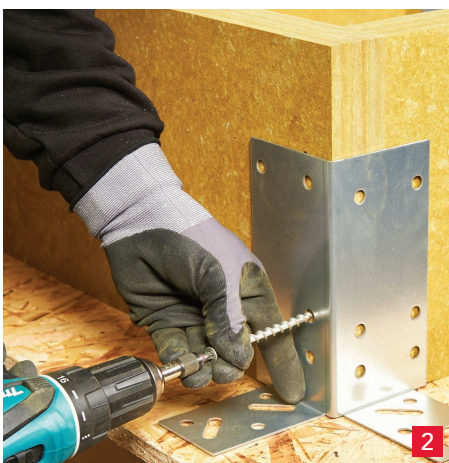
Asennukseen käytetään Redair Link -kulmakiinnikkeitä ja mukana toimitettuja ruuveja.
