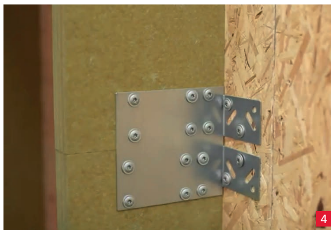
Jos jatkokiinnikkeitä käytetään, kiinnitetään Redair Link -järjestelmä jatkokiinnikkeistä seinään kohdekohtaisilla ruuveilla.
