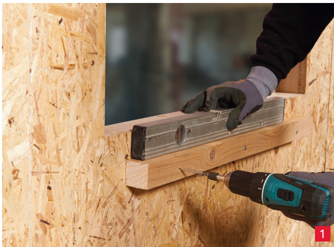
Esimerkki: Redair Link -järjestelmän tilapäinen asennustuki.
