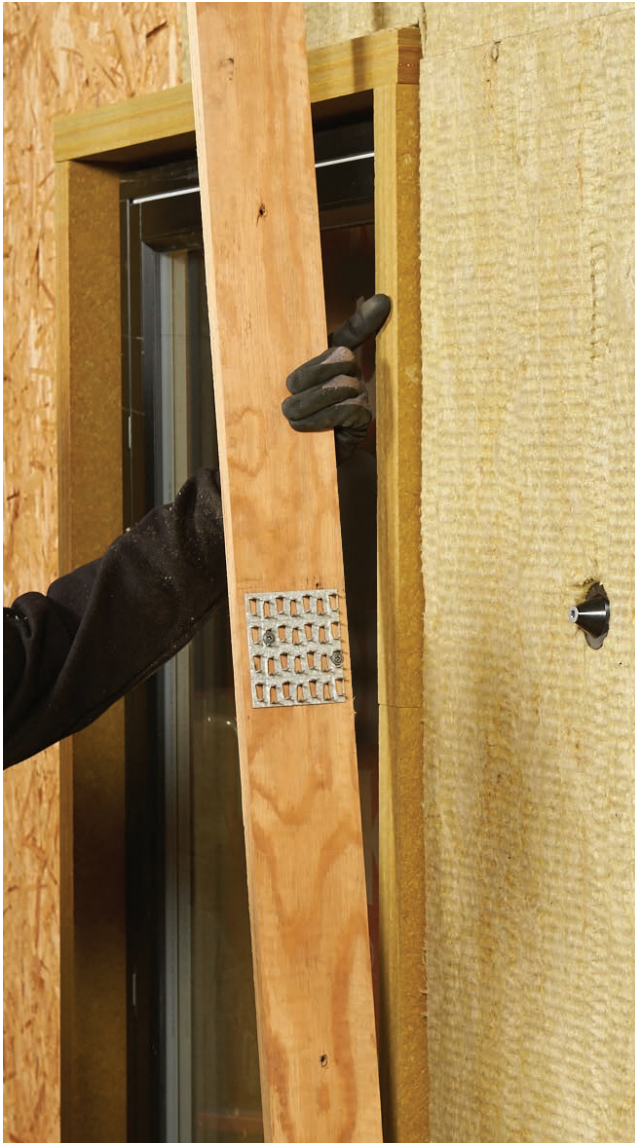
Asenna rangat pystysuuntaisesti niin, että rangan taustapuolella oleva kitkalevy tulee eristettä vasten.
