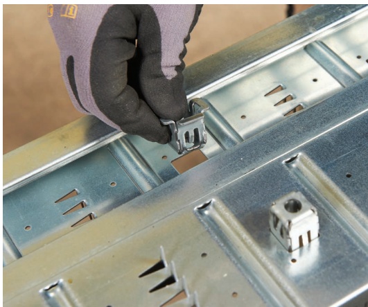
Klipsit painetaan kiinni teräsrankassa oleviin reikiin.
