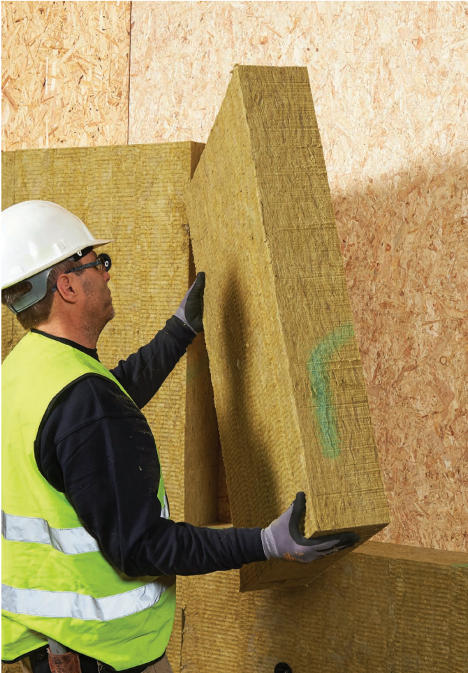
Redair Multi -eristejärjestelmän asennus aloitetaan eristeen asentamisella
