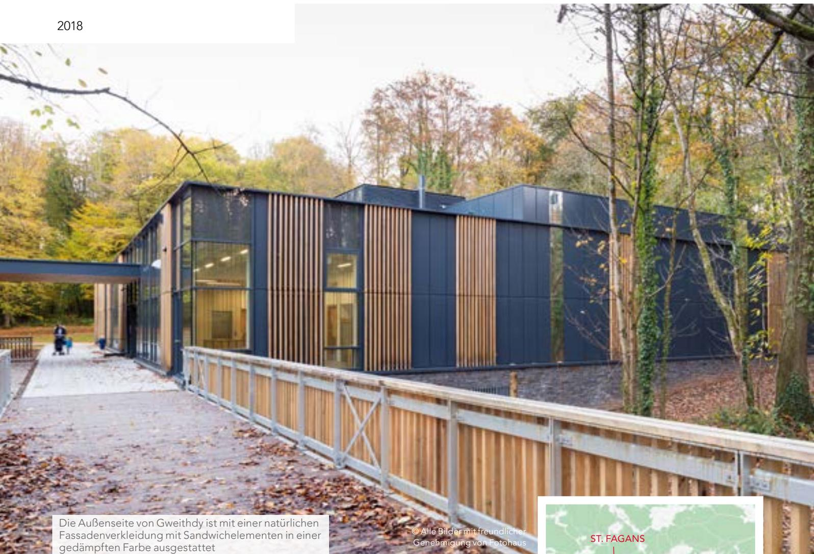
Die Außenseite von Gweithdy ist mit einer natürlichen Fassadenverkleidung mit Sandwichelementen in einer gedämpften Farbe ausgestattet
