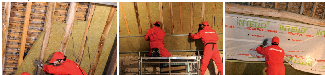
1 Pose de la première couche d'isolant
